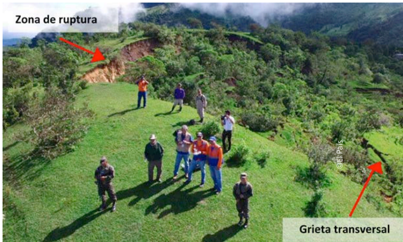
Ilustración 3: Deslizamiento permanente (deslizamiento rotacional) en el cerro Guarín, Honduras.
